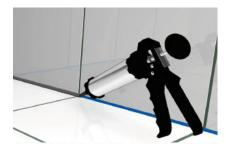
Übergänge zwischen Boden und Wand mit geeignetem Silikon 2-fach verflankt abdichten.
