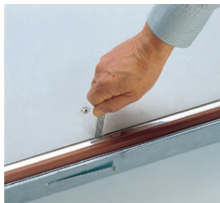
Griffschleife zum Wegheben der Brandschutzplatte
