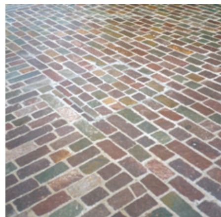
Befüllt mit Pflastersteinen praktisch unsichtbar
