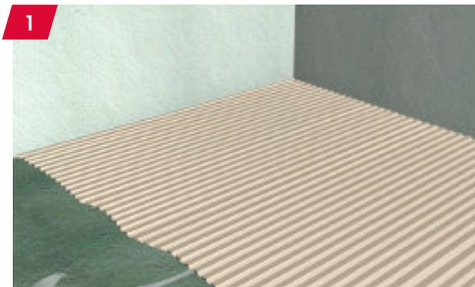
1. Schneiden Sie die Entkopplungsbahn auf das Maß des zu entkoppelnden Untergrundes.
