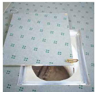
Eingebaut im Büro (Putzschacht), ausgelegt mit Teppich
